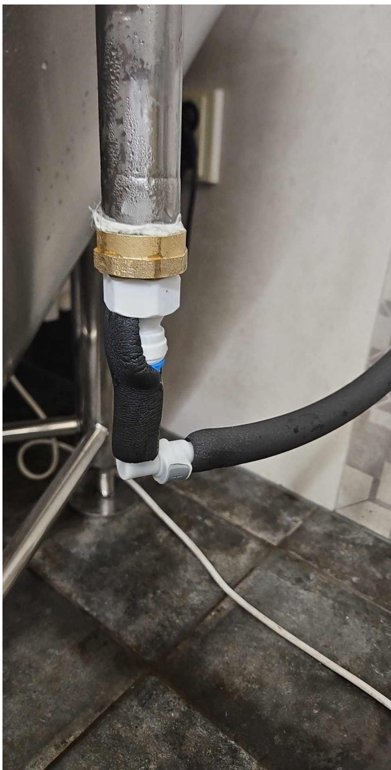
Detail hadic s napojenu izolaci.
